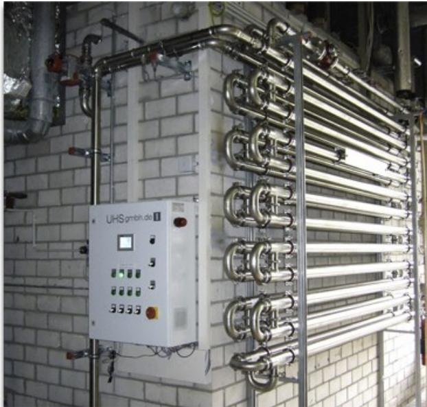
Rohr- in Rohr Wärmetauscher zur Wärmerückgewinnung aus stark verunreinigten Medien, für kleine und große Volumenströme, z. B. aus Abwasser.
